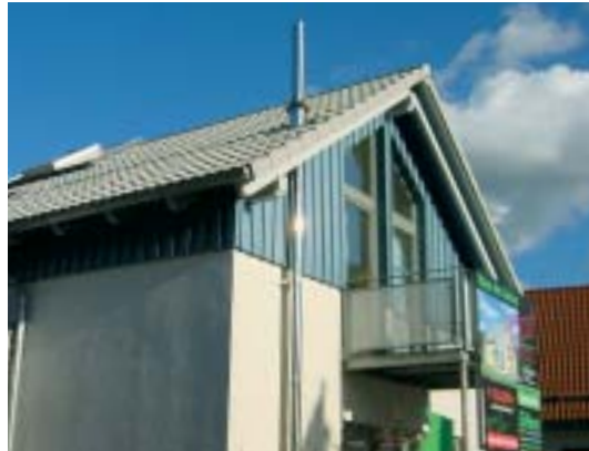
Bild 24: Gemessenes Fertighaus aus Holzständerbauweise (Meßkurve 8)
